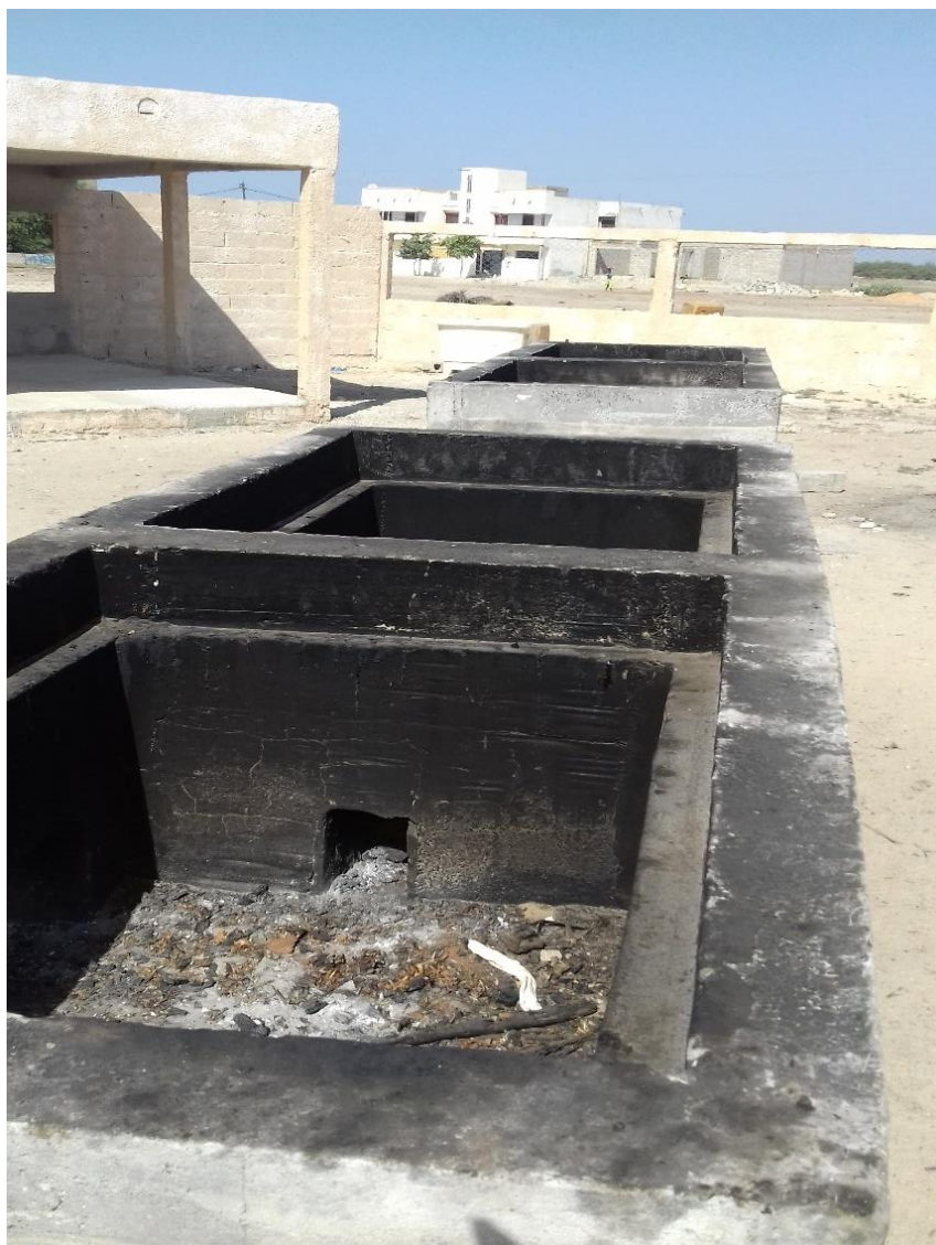
Figure 9: Site de Yénne Todd (avant les travaux entamés par le projet)
