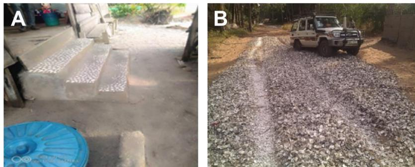
Figure 4: Utilisation des produits de la pêche aux mollusques et crustacés, y compris (a) l'utilisation des coquilles de coques pour carreler les escaliers et (b) l'utilisation des coquilles d'huîtres dans la construction et l'entretien des routes de desserte par les communautés côtières.
