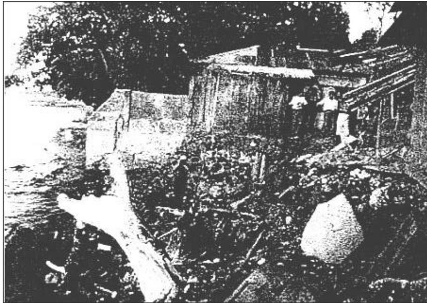
**Gambar 3b. Erosi pantai di Malalayang 2 Manado akibat pembangunan seawall**
