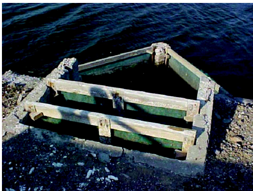
Figura 3. Los filtros en las compuertas de entrada y salida de los estanques deben ser limpiados, revisados y reparados frecuentemente para evitar la fuga de camarones o la entrada de predadores.
