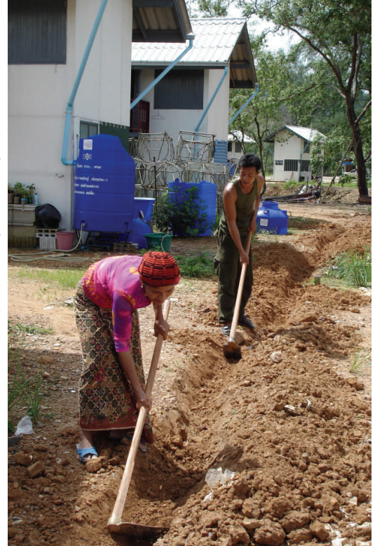
ชาวบ้านหาดประพาส หมู่ที่ 2 ช่วยกันขุดวางท่อประปา
