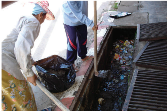
ชาวบ้านกำพวน ช่วยกันขุดลอกท่อระบายน้ำ
