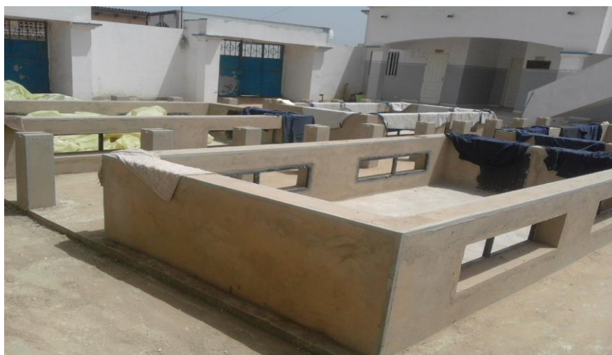
Figure 3. Début d'installation de fours solaires à l'Unité de transformation moderne à Cayar
