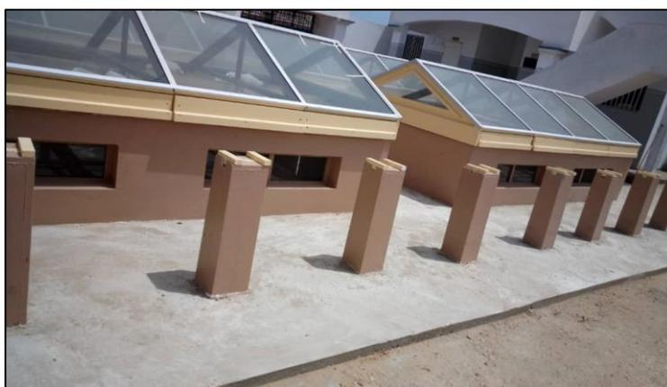
**Figure 21. Séchoirs solaires installés dans le centre de transformation moderne de Cayar**
