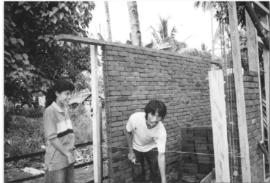
Gambar 12. Pembangunan MCK untuk mengatasi sanitasi lingkungan yang buruk. (Foto: Proyek Pesisir Suawesi Utara).
