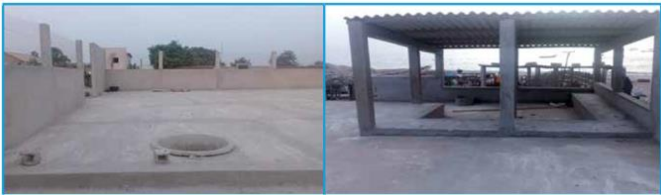
Figure 3. Aire de transformation de Mballing village après réhabilité avec l'appui du projet USAID/COMFISH Plus
