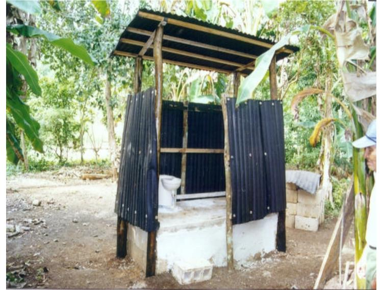
La edificación de la caseta, varía según los materiales que existan en la región o que se tengan a la mano, por ejemplo: el techo puede ser de guano, varillas, lámina (de metal, cartón o asbesto), tablas, etc.
