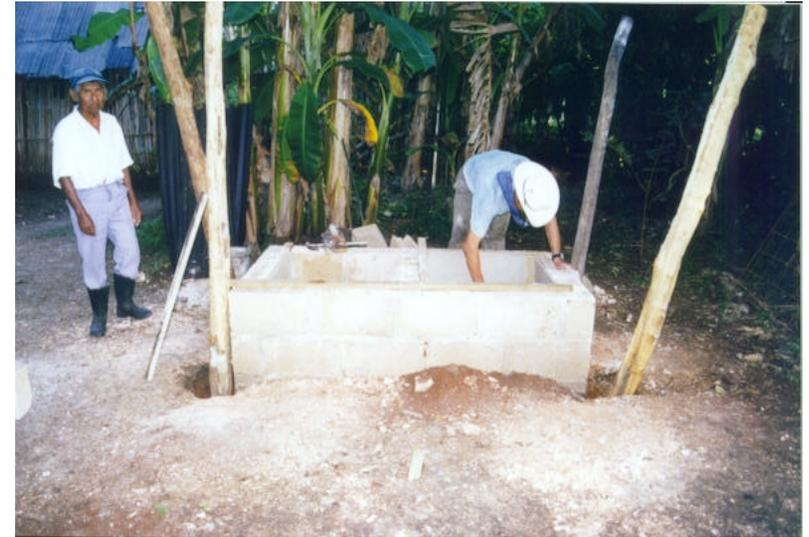
4. En las esquinas inferiores frontales del rectángulo o del sanitario se dejarán unas aberturas las cuales funcionarán como compuertas de descarga. Dichas compuertas se sellarán con bloques "falsos" de 22 cm. de ancho para que cuando los depósitos se llenen y se haya procesado el abono orgánico, este pueda ser removido.
