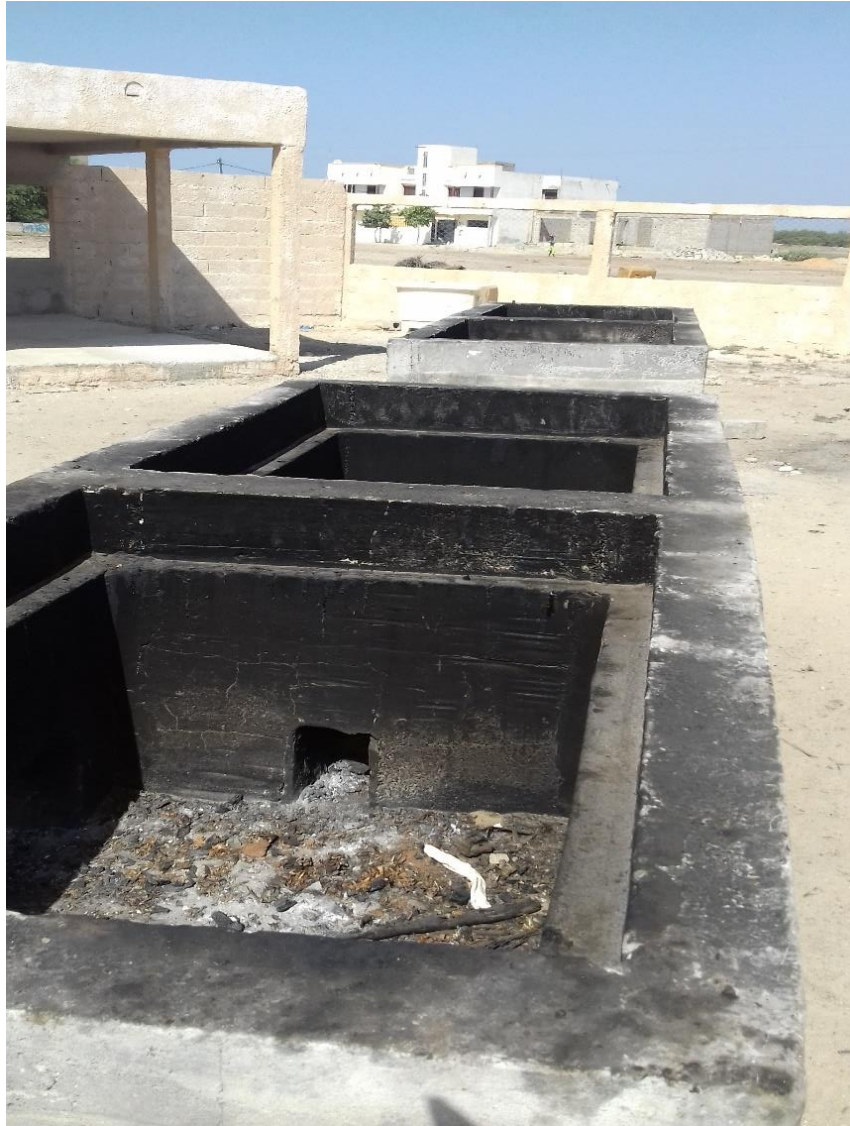
Figure 9: Site de Yéne Todd (avant les travaux entamés par le projet)
