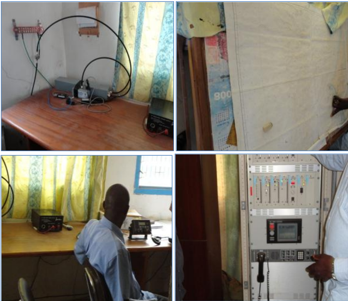
Photos 6, 7, 8,9 : AIS installé récemment, carte des côtes sénégalaises et des eaux internationales, radio VHF et armoire SMDSM
