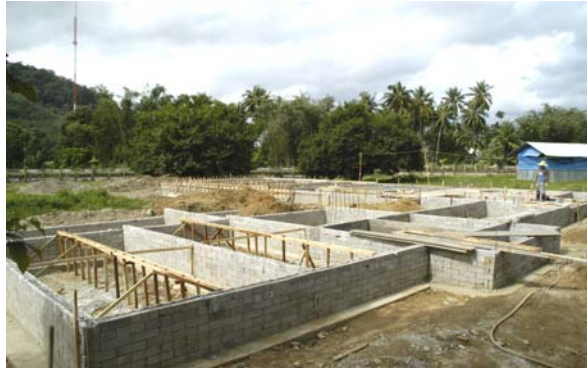
ฐานรากของอาคารศูนย์การเรียนรู้ชุมชนกำพวนดำเนินการก่อสร้างเสร็จแล้ว
