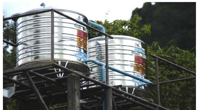
ถังสเตนเลสเก็บน้ำที่บ้านทะเลนอก ขนาด 1000 ลิตร 2 ถัง
