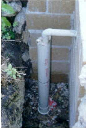
Es importante mencionar que el tubo debe pegarse a la tapa, debido a que va ir cambiando el contenido del filtro. Para colocar el filtro se deben poner un molde hecho con tablas, de tal manera que el filtro quede fijo y no se mueva, esto también sirve para facilitar su salida al momento de cambiarlo. El cambio del contenido del filtro se hará cada cuatro años.
