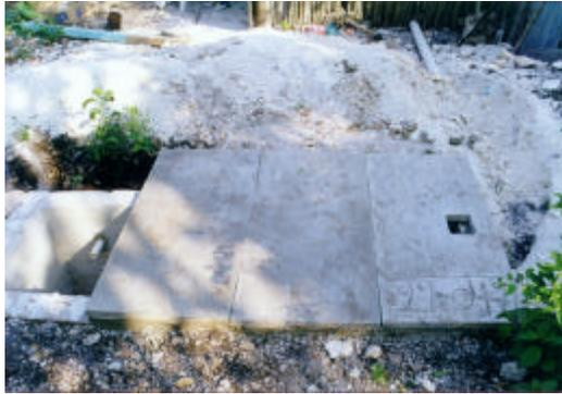
Durante el sellado de la losa se deberán tomar las precauciones debidas para evitar que queden rendijas por donde pueda infiltrarse agua del exterior.
