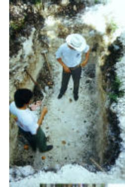
Al terminara la excavación, se nivela el suelo del fondo del foso.
