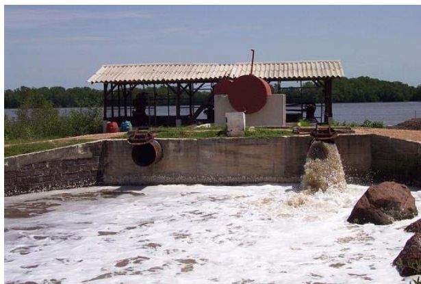
Estación de bombeo de una granja camaronera.
