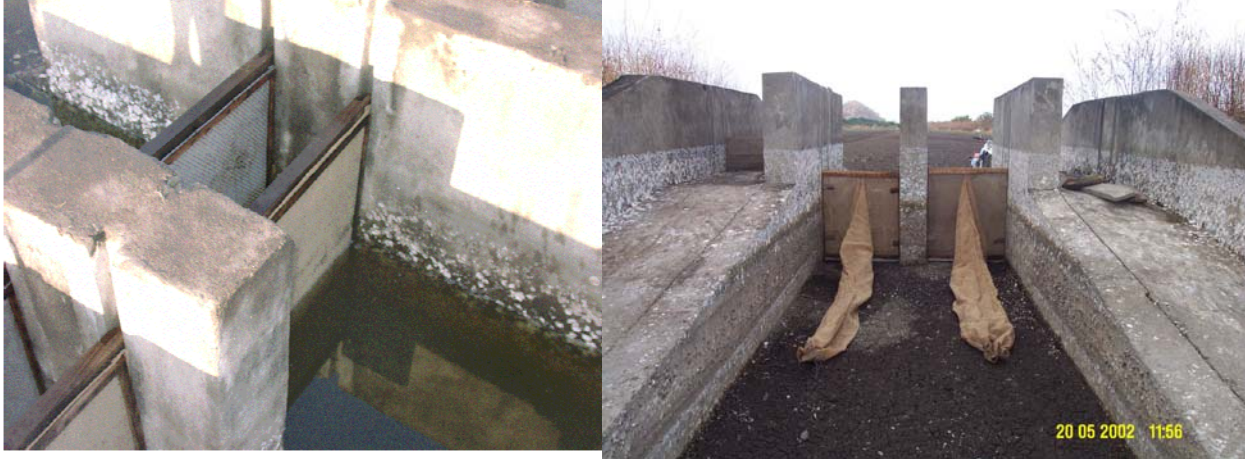
Filtros usados en una camaronera en las compuertas
