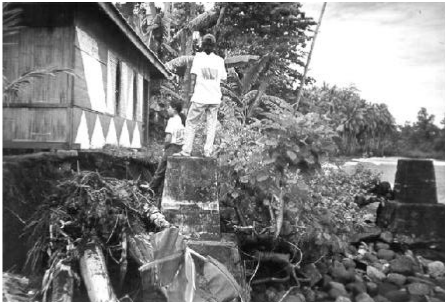
Kondisi bangunan Pusat Informasi Masyarakat yang mengalami erosi pada bulan Maret 1999. Foto: Erick Armada
