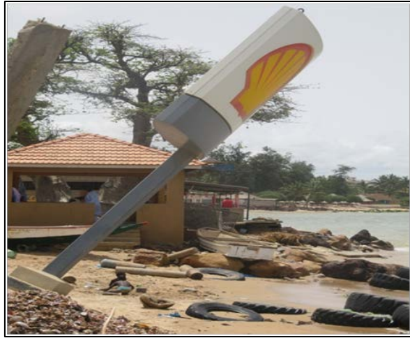
Photo 32: Station d'essence menacée par l'érosion côtière à Saly
